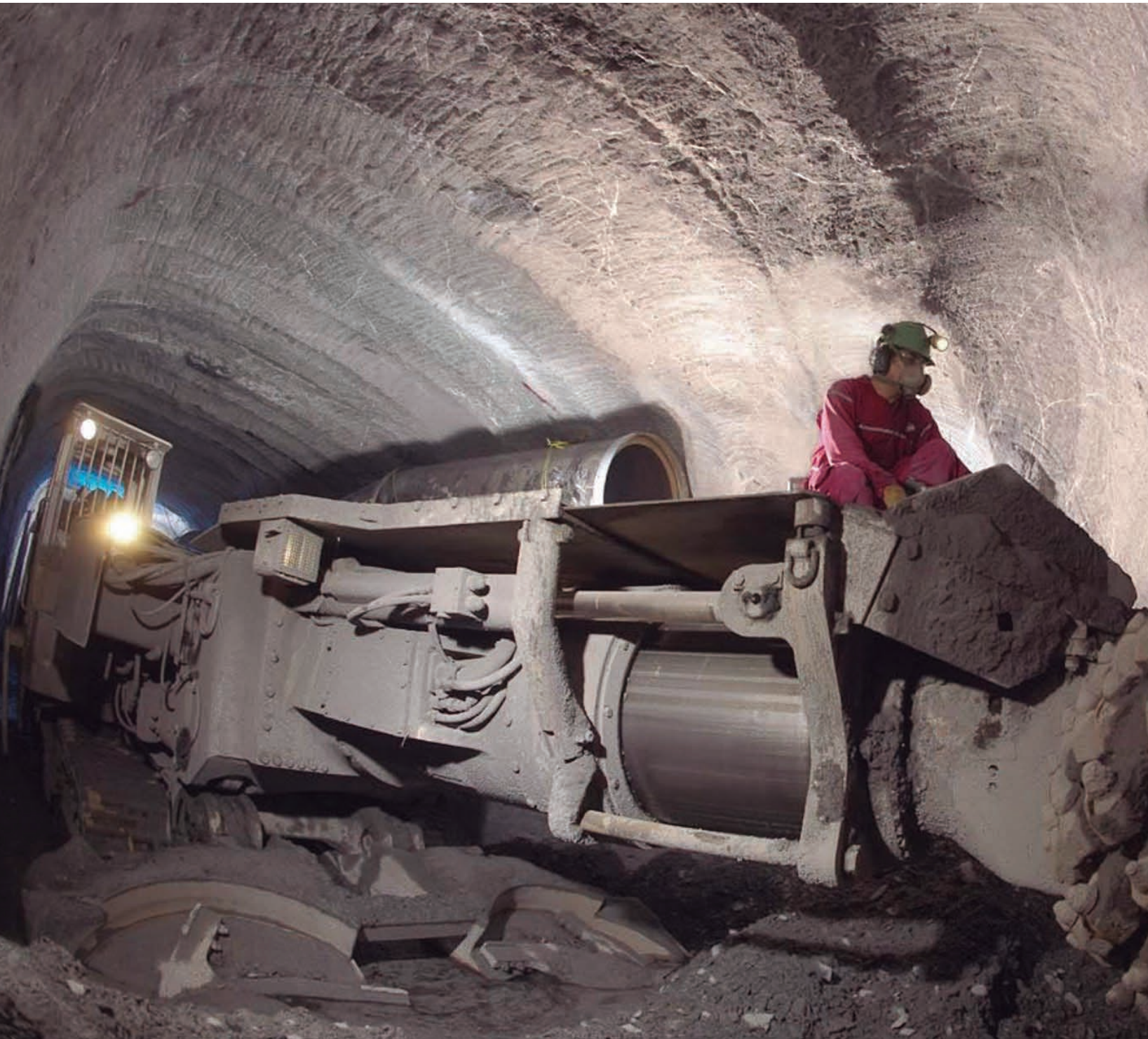
Elaboración de Túneles
