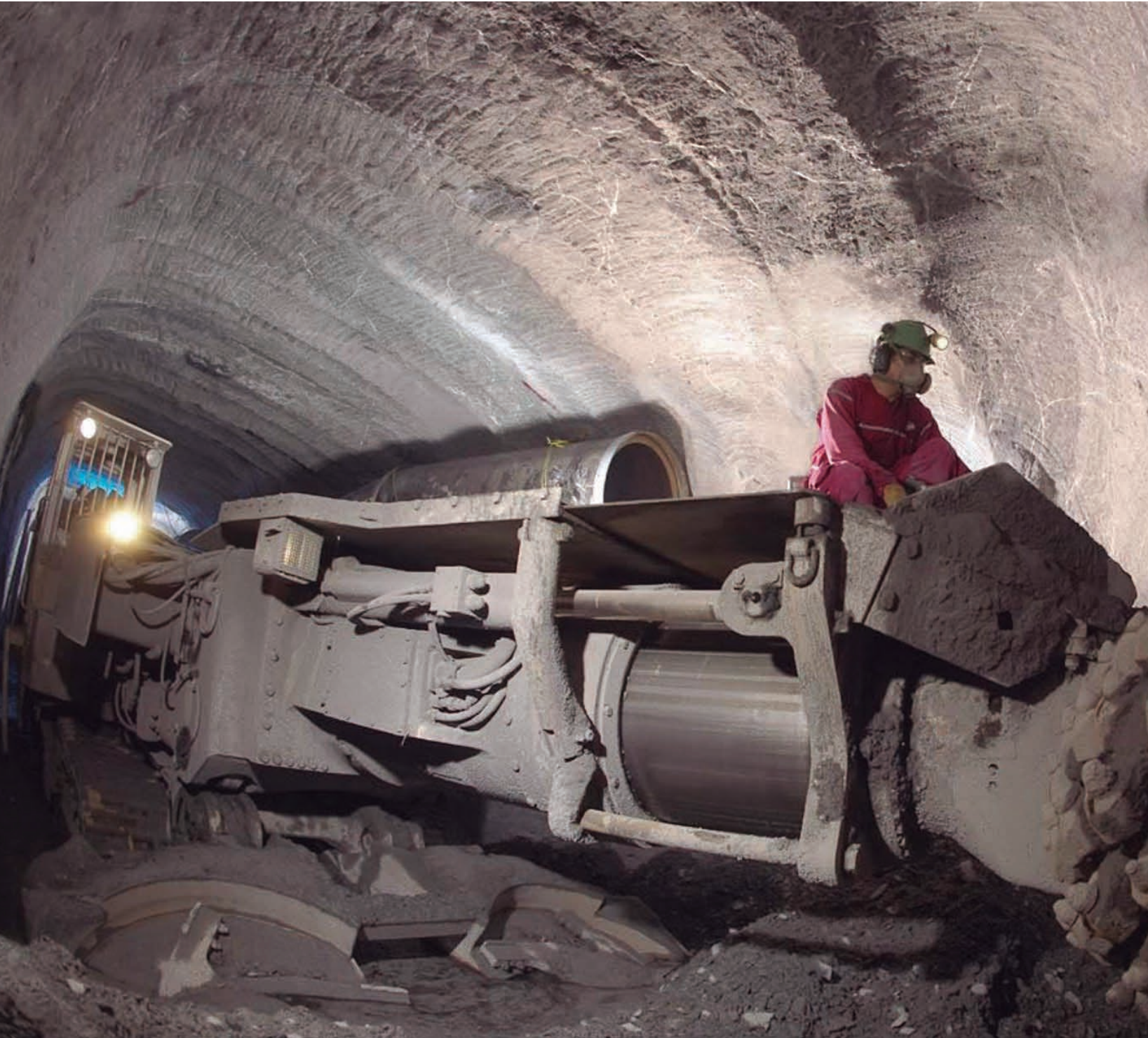
Elaboración de Túneles
