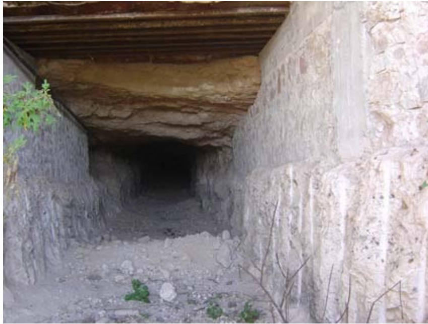
Foto 6.- Vista del Socavón Cortés.
