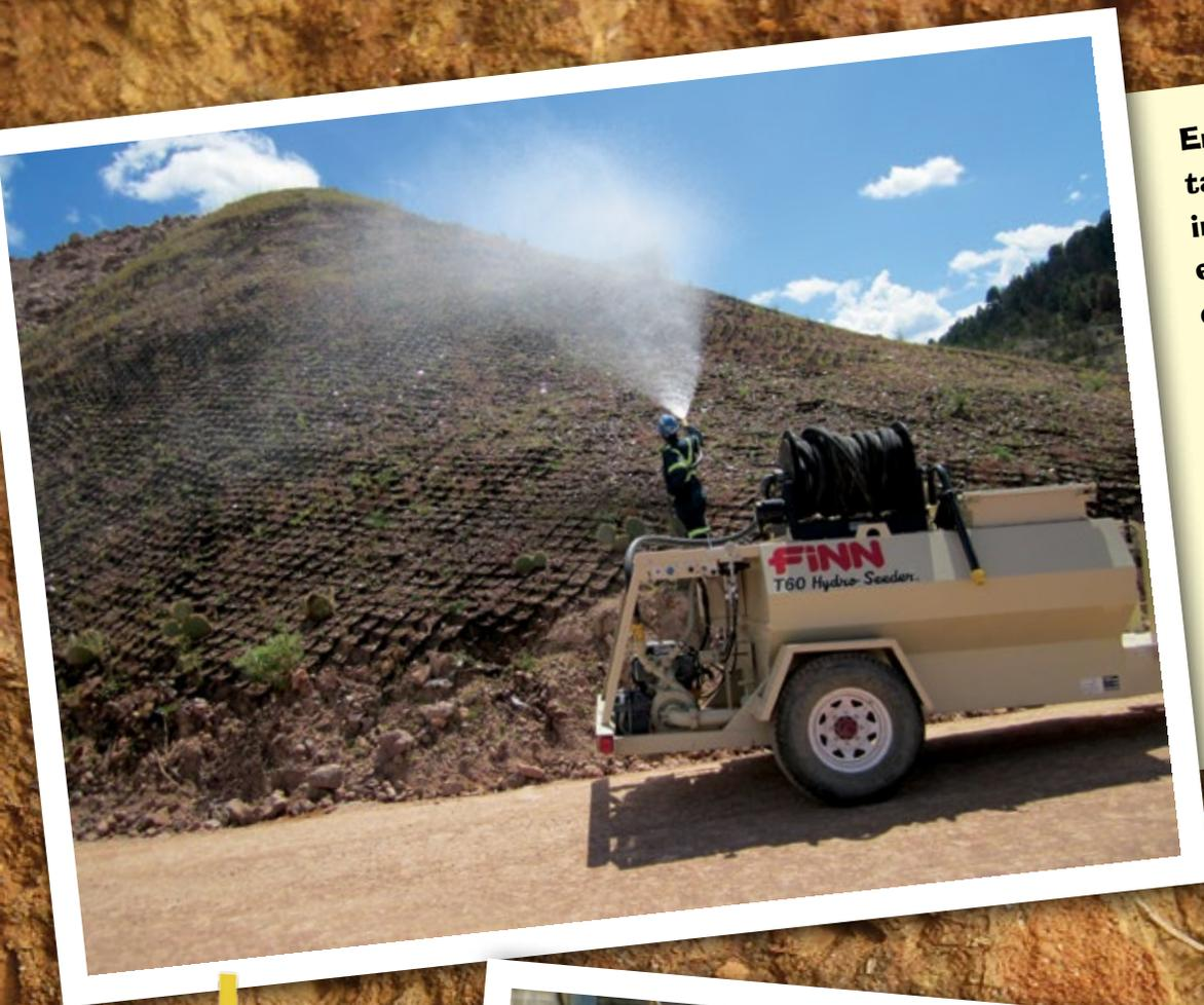
En algunos taludes se instalan mallas especiales que evitan los deslizamientos y la erosión. En estos terrenos se aplica una mezcla de agua, semillas y nutrientes que fijan el suelo y sirven al proceso de reforestación.
