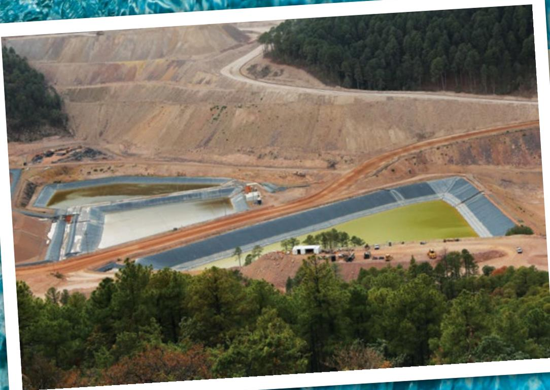
**Las piletas en las que el agua se deposita para reusarse en el proceso se recubren con una capa plástica impermeable llamada geomembrana.**
