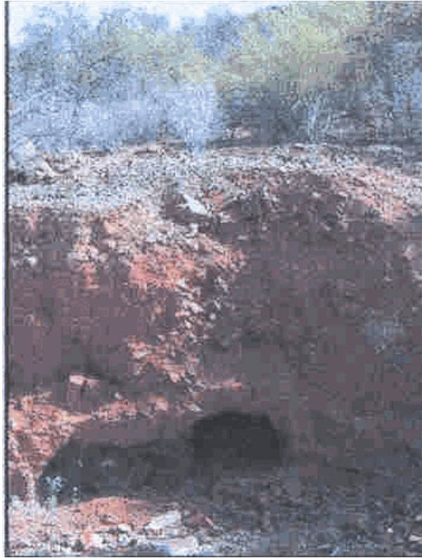
Socavón Subterráneo en Gravas de Placer
