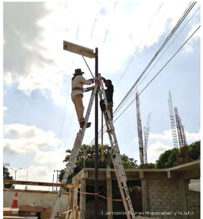
Instalación alumbrado público, Jiquipilas
